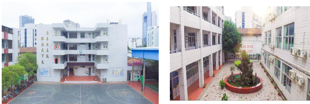
图 5.1-1 搬迁前校区现状照片
