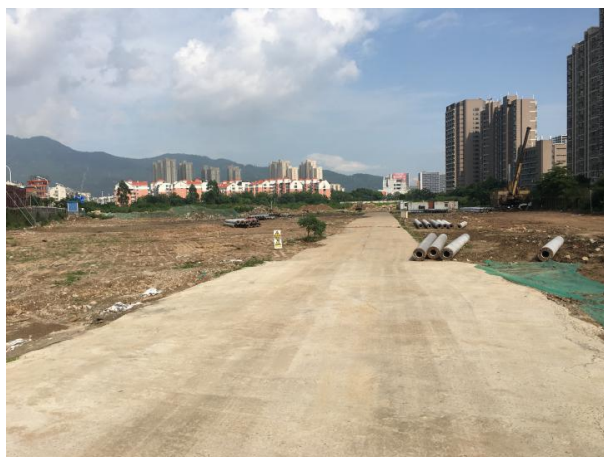
场地现状—已平整土地
