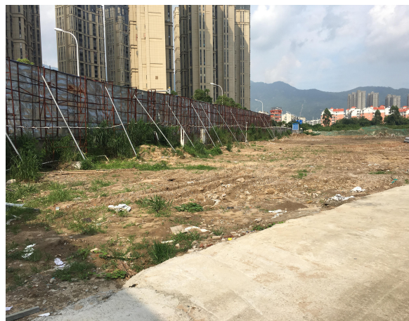
场地现状—已平整土地
