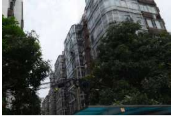
项目西侧裕轩苑
