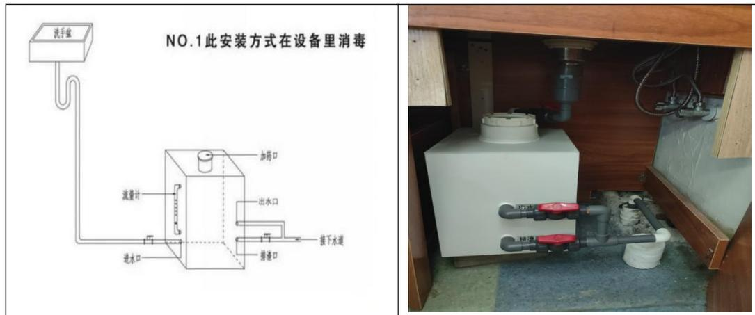
图 4-2 消毒设备接管及消毒方式
